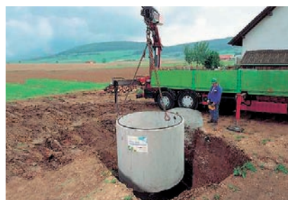
Montage eines Versickerungsschachtes
