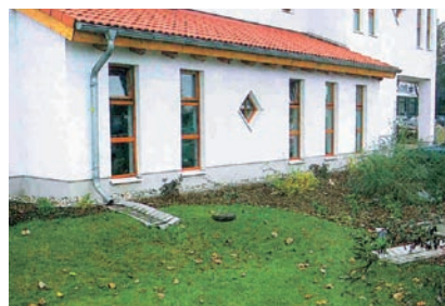
Versickerungsmulde auf einer Rasenfläche
