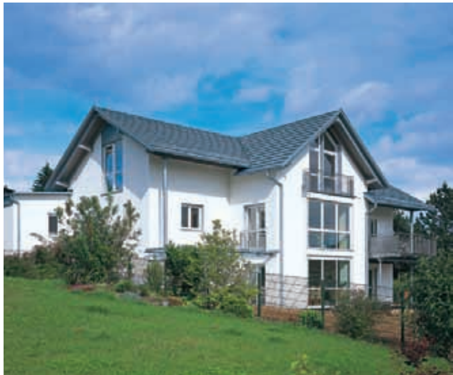
Abb. 35: Einfamilienhaus, Wetzlar, Deutschland
