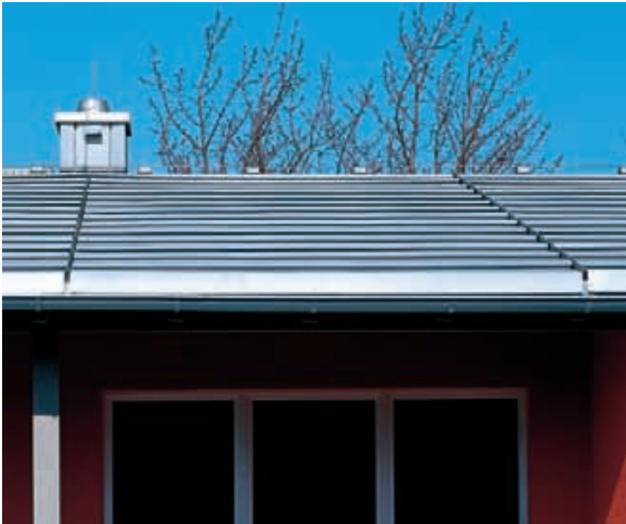
Abb. 3: QUICK STEP-SolarThermie, Wohnhaus, Dresden, Deutschland
