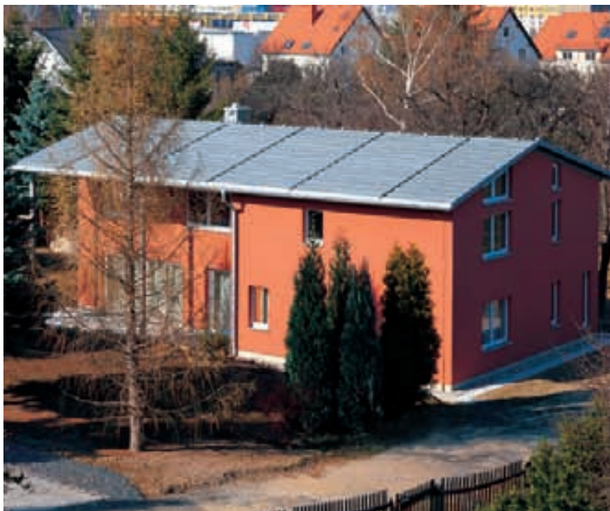
Abb. 32: Einfamilienhaus, Dresden, Deutschland
