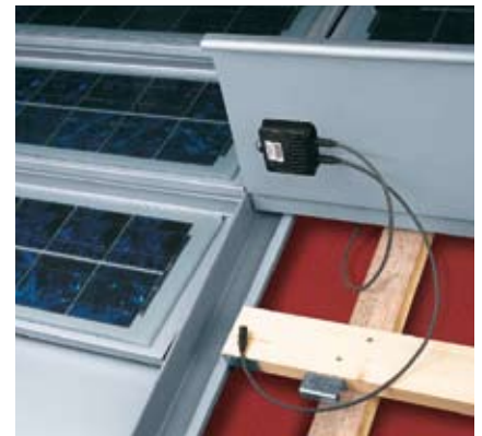
Abb. 17: Verkabelung der QUICK STEP-Solar PV Module
