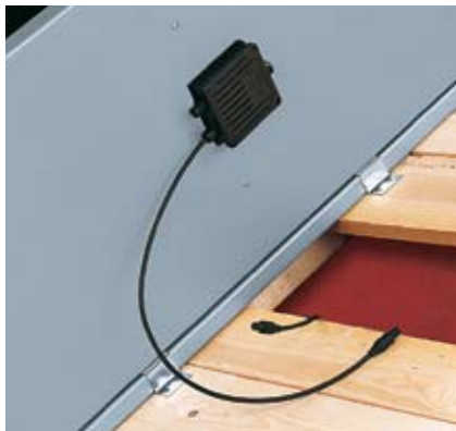
Abb. 30: Verkabelung der Solar PV-Module
