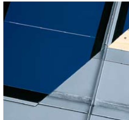
Abb. 26: Einfacher Querfalz mit aufgelötetem Zusatzhaftstreifen
