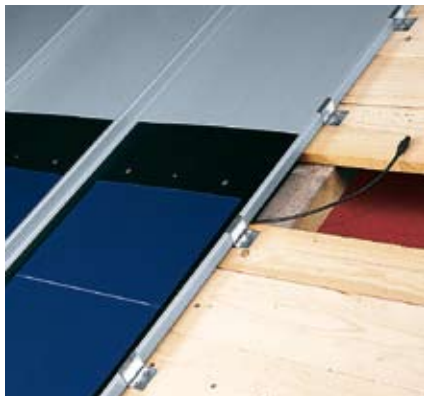
Abb. 29: Aussparung der Holzschalung zur Aufnahme der Anschlussdose
