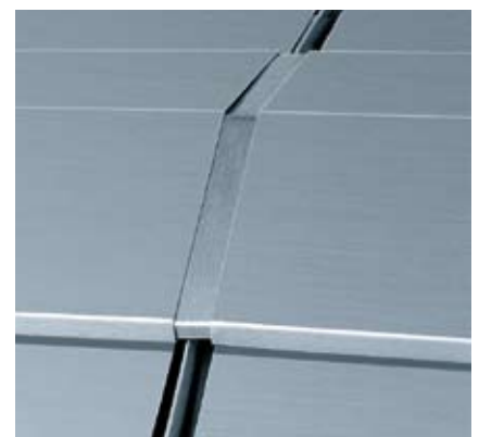
Abb. 12: Firstabschluss, QUICK STEP – Das RHEINZINK Treppendach
