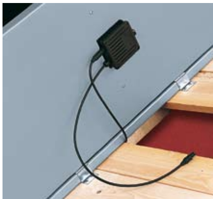
Abb. 31: Verkabelung der Solar PV-Module
