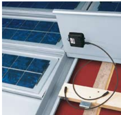
Abb. 16: Verkabelung der QUICK STEP-Solar PV Module
